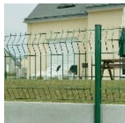
Installatie met betonplaat
